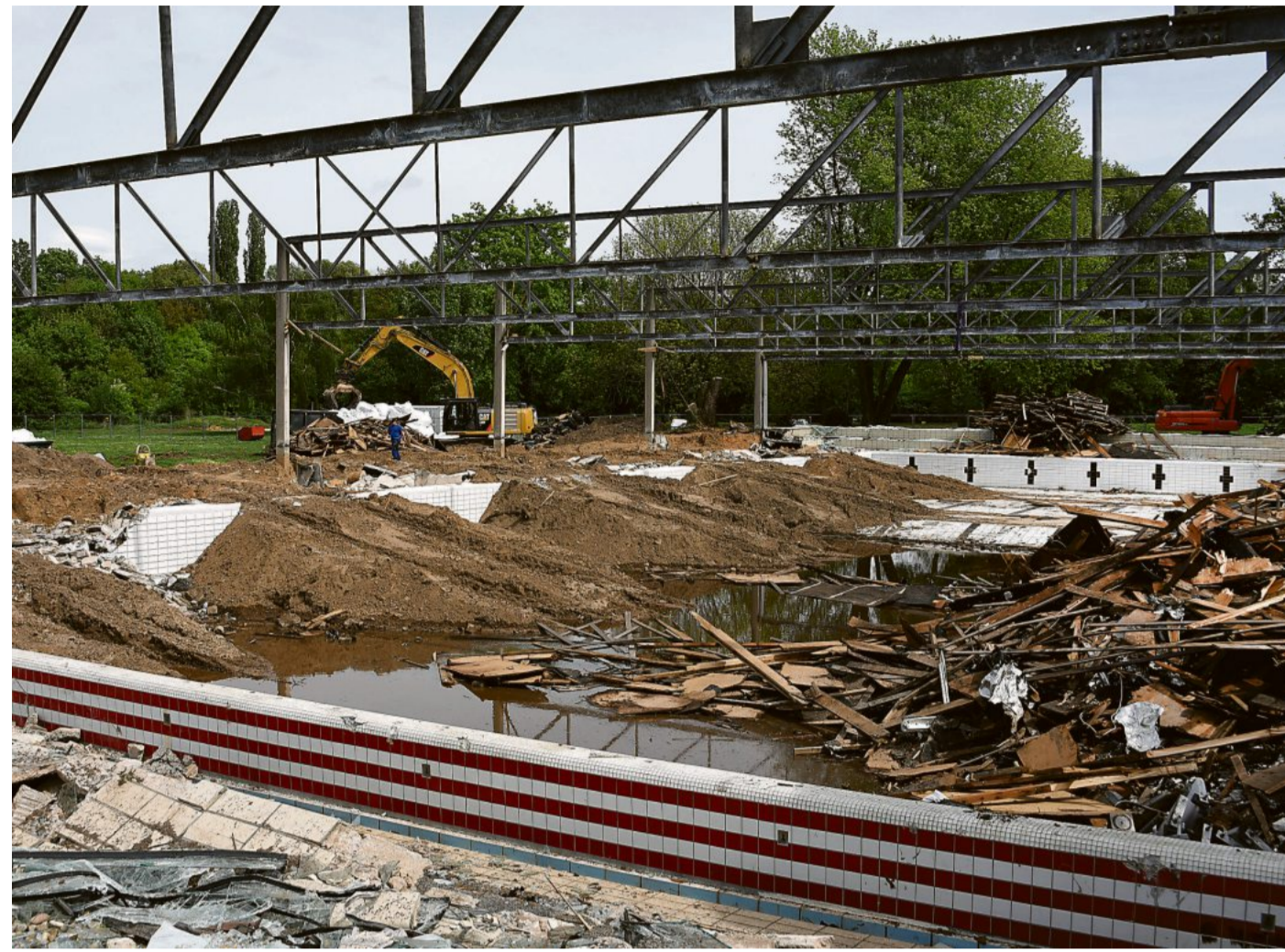
Großbaustelle: Vom Darmstädter Nordbad soll in knapp einem Monat nichts mehr übrig sein.
